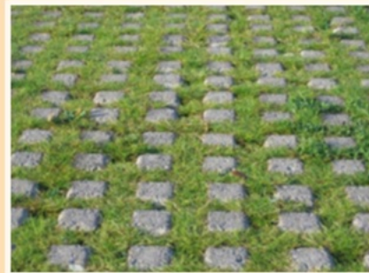
Beperking verharding door toepassen rijlopers en grasbetontegels
