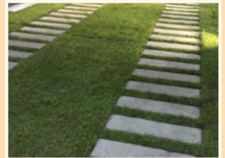
Beperking verharding door toepassen rijlopers en grasbetontegels
