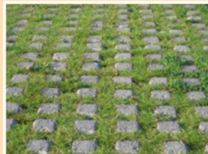
Beperking verharding door toepassen rijlopers en grasbetontegels
