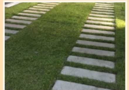
Beperking verharding door toepassen rijlopers en grasbetontegels
