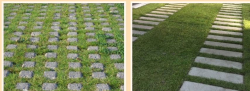
Beperking verharding door toepassen rijlopers en grasbetontegels
