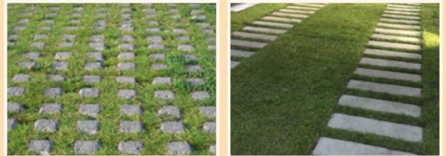
Beperking verharding door toepassen rijlopers en grasbetontegels
